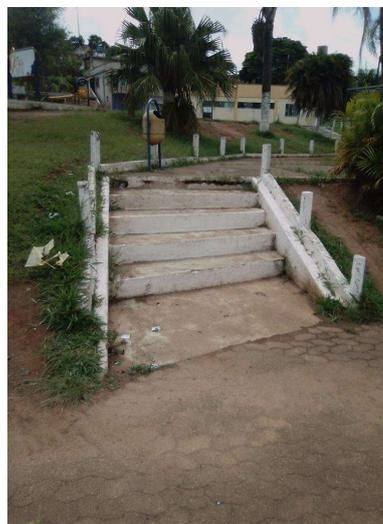
**FOTO 11 e 12: Arquibancada e escada danificadas e com pintura desbotada .**
