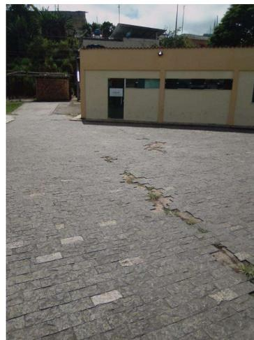
**FOTO 15 e 16: Piso das quadras sem pintura e piso do pátio 3 danificado.**
