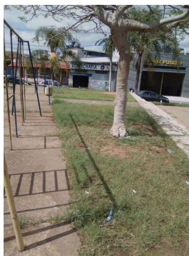
**FOTO 09 e 10: Pátio central em piso de concreto com juntas invadida por vegetação e canteiro com falhas na grama.**
